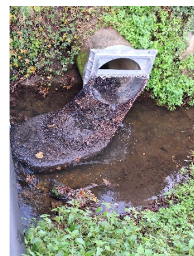
Filet installé rond-point de l'hôpital
