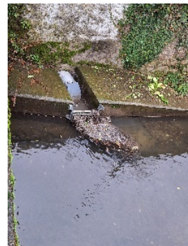
Filet installé rue des Framboisiers
