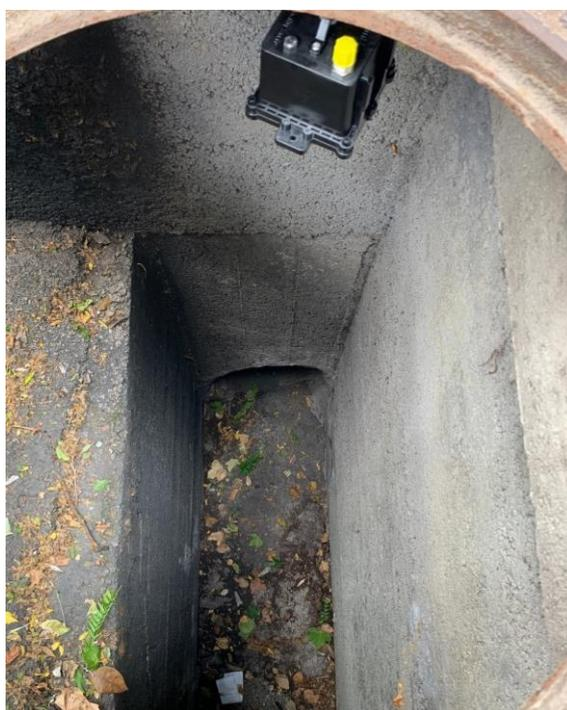
*Figure 9 Capteur de niveau HummBox installé dans un avaloir de Marseille métropole (source : GreenCityZen).*
