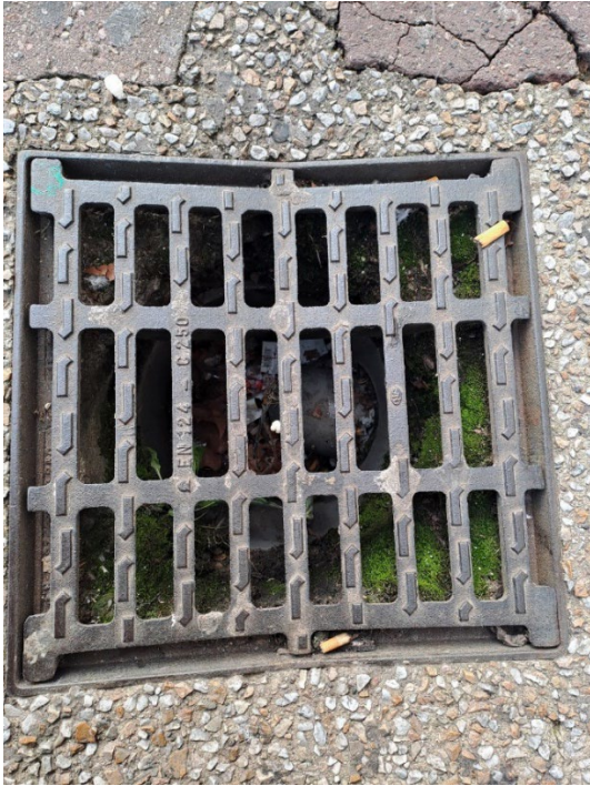
Figure 7: Macrodéchets (mégots, emballages alimentaires, canettes, etc.) présents dans les avaloirs malgré la présence du dégrilleur (©Cedre)
