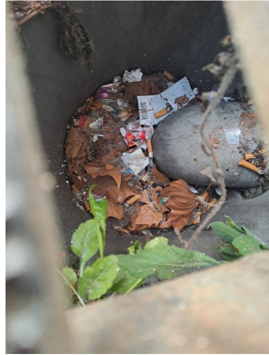
Figure 7: Macrodéchets (mégots, emballages alimentaires, canettes, etc.) présents dans les avaloirs malgré la présence du dégrilleur (©Cedre)
