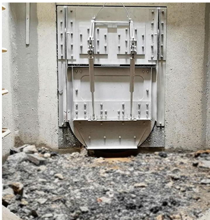
Figure 1. Exemple de vanne hydrodynamique de la société F-REG (Crédit photo : F-REG).
