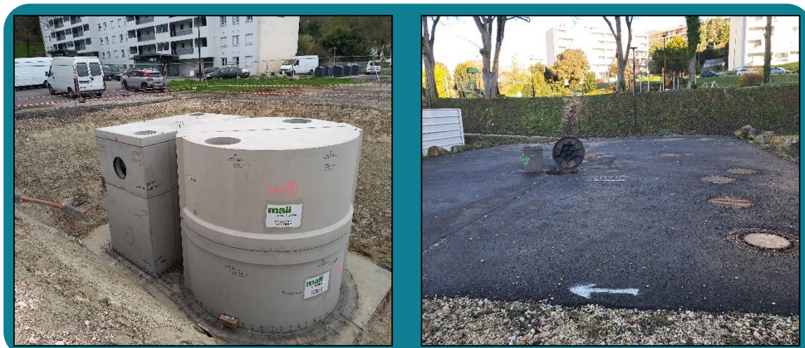
Installation du séparateur hydrodynamique dans le quartier de Bel Air – Grand Front. Crédits : GrandAngoulême.
